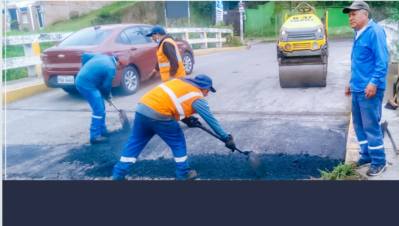
Trabajos de bacheo EPMMOP gestión GAD Alangasí
