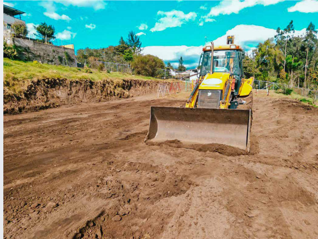
Trabajos de nivelación y conformación del área deportiva del jardín de infantes Ovidio Decroly .
