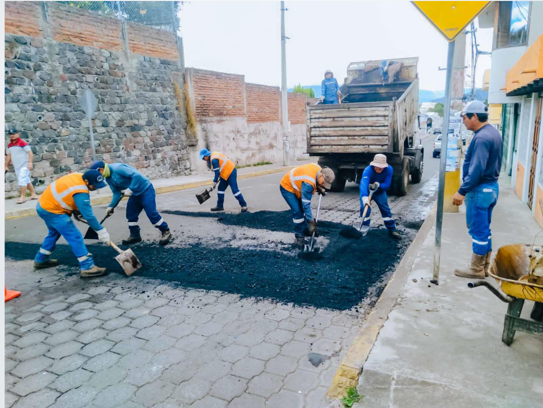
Trabajos de apoyo a la EPMMOP en el arreglo de dos reductores de velocidad en la calle Puerto Rico y Av. Río Pastaza
