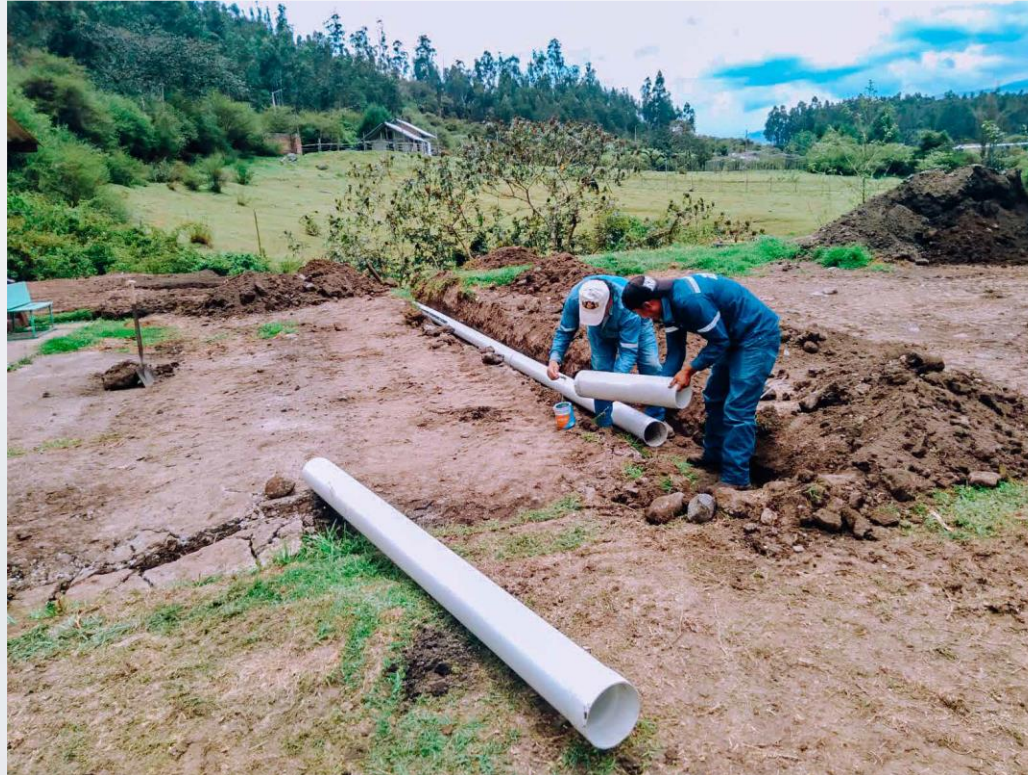
Trabajos de nivelación y excavación para la instalación de tubería de desagüe en la iglesia de San Antonio de El Tingo .
